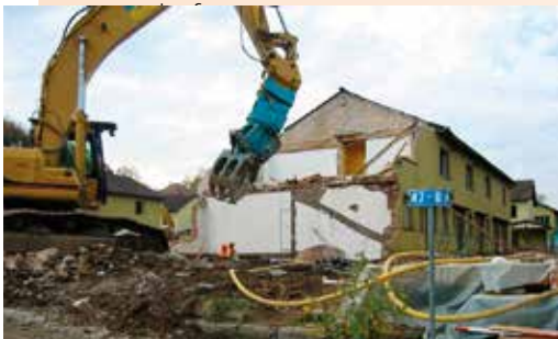
August: Start mit dem Rückbau Am Katzenbach I.
