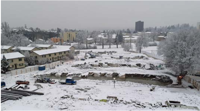
Schadstoffsanierung und Abbrucharbeiten Ersatzneubau Buchwiese ab Oktober 2022.
