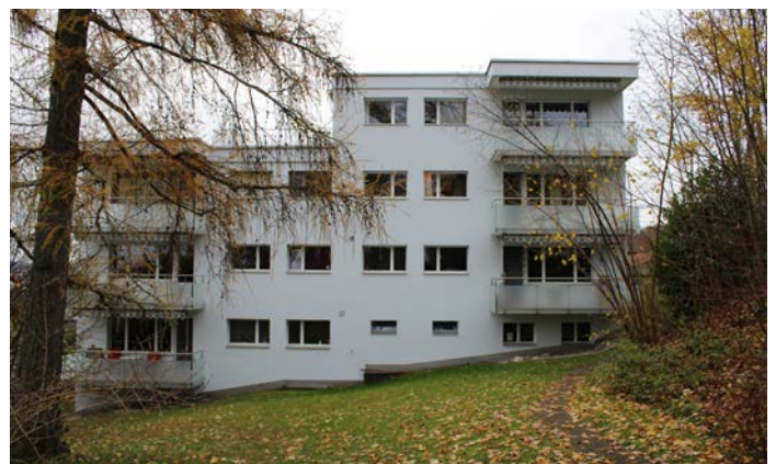
Siedlung Ahorn - Fassadeninstandsetzung
