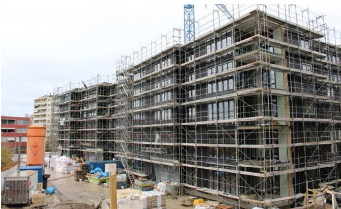
Ersatzneubau Riedacker - Fassadenmontage und Innenausbau
