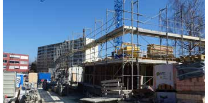
Langsam wachsen die Rohbauten im Riedacker in die Höhe
