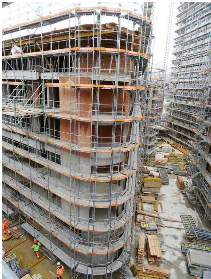
klar erkennbar die Form vom Haus Luigi
