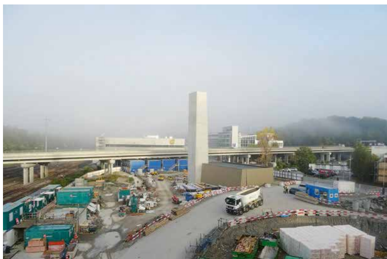
die Energiezentrale mit der Holzschnitzelheizung
