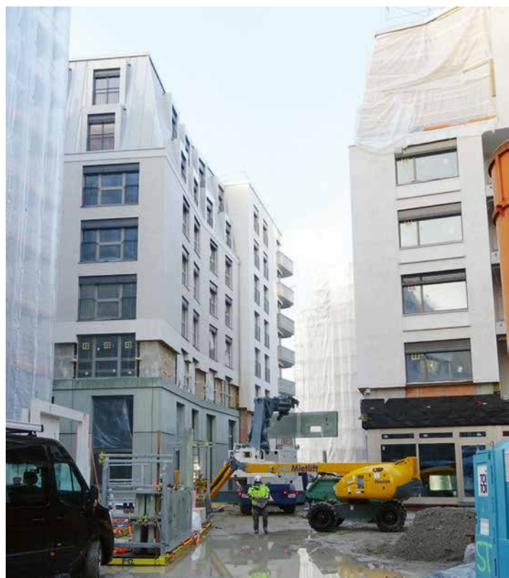
Fassadenarbeiten an den Häusern Oscar (links) und Maria (rechts)
