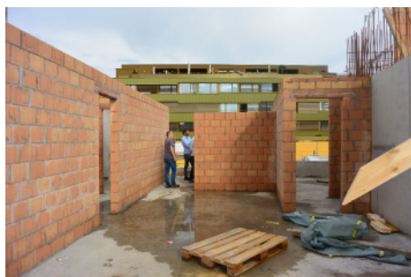
Maurerarbeiten im EG
