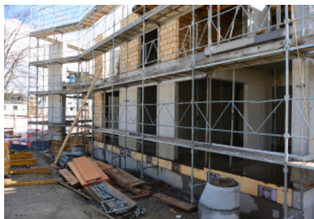
Das Ü60-Haus nimmt Gestalt an
