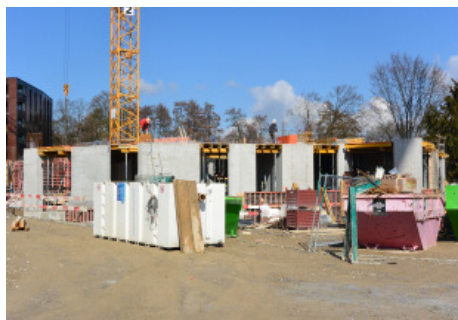
Schalungsarbeiten Decke über EG (Haus B)
