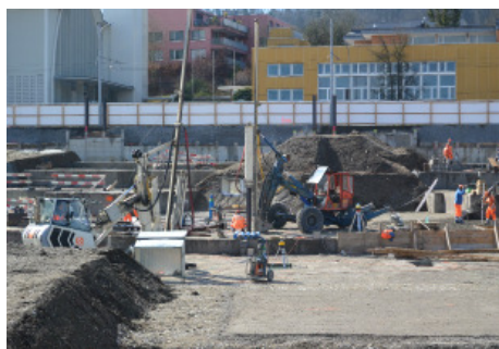
Die Pfählung beginnt .....
