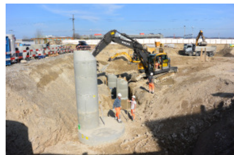
Aushub der Baugrube in Rümlang
