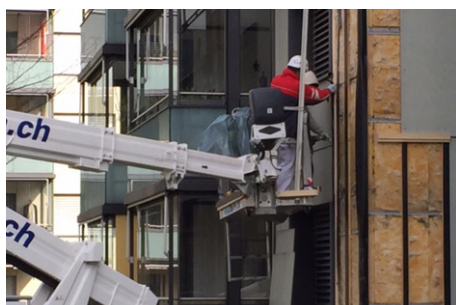
Monteur in luftiger Höhe bei der Arbeit (Saatlen)
